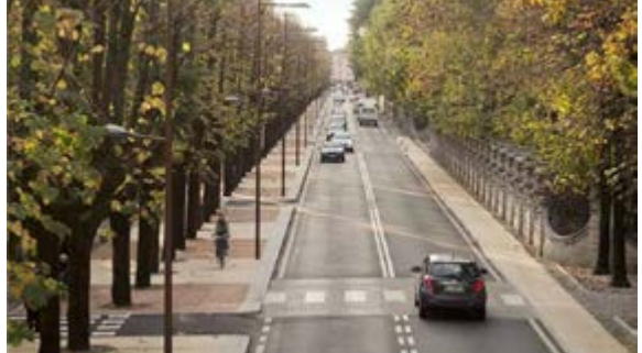
La riqualificazione ex Strada Statale II
